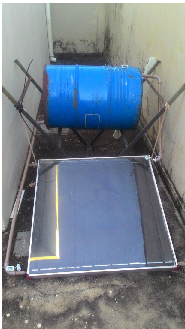
FIGURA 4 – Projeto de aquecimento de água com circulação forçada
